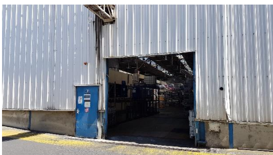
Local Stockage matières premières liquides
