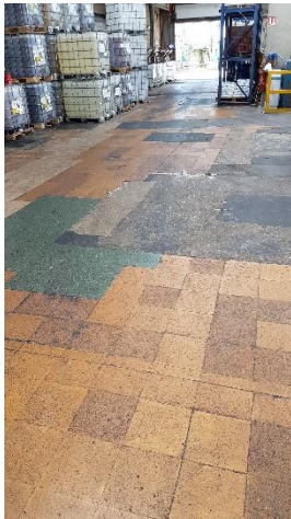
Sol en patchwork dallettes et béton
