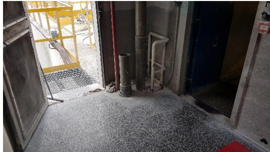
Accès passerelle et trémie d'escalier
