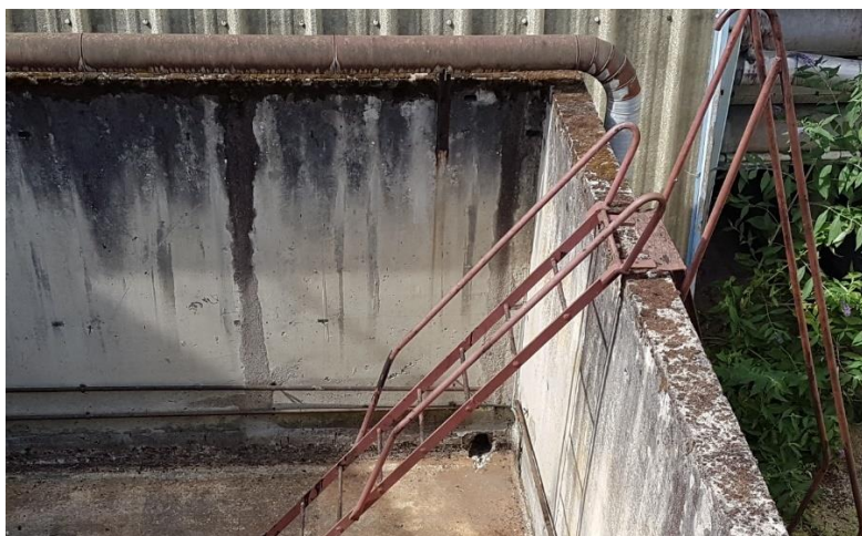
Présence d'un carottage pour les écoulements
