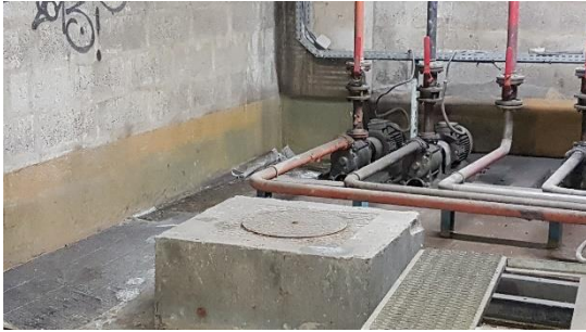
Résine appliquée à hauteur de rétention Cuve 120B
