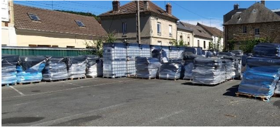
Absence de rétentions sur les IBC stockés dans le parc à déchets
