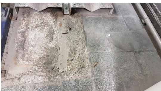
Dallettes de sol et ancien socle béton
