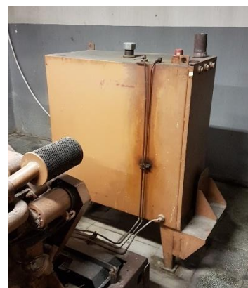
Absence de rétention sur les cuves diesel des 2 groupes motopompe des sprinklers
